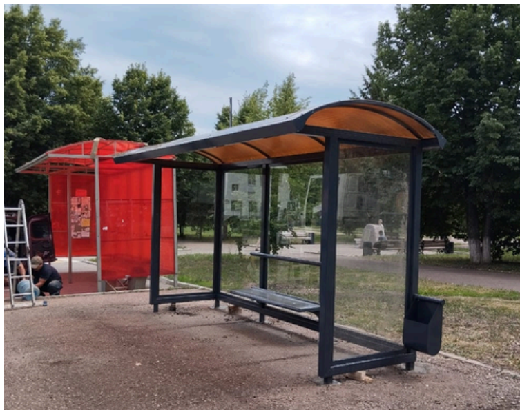
Остановочный павильон "Горожанин" Остановка наземного транспорта "Синтез-Каучук"
